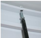
Dach von der Unterseite silikonieren und auf die Seitenwände, Rückwand und Rahmen des Rundduschenteiles aufsetzen und ausrichten. Mit dem beiliegenden 2.8mm Bohrer die Löcher im Dach vorbohren und mit 7 Stück M6\*20 Schrauben, Unterlegscheiben und Muttern verschrauben.
