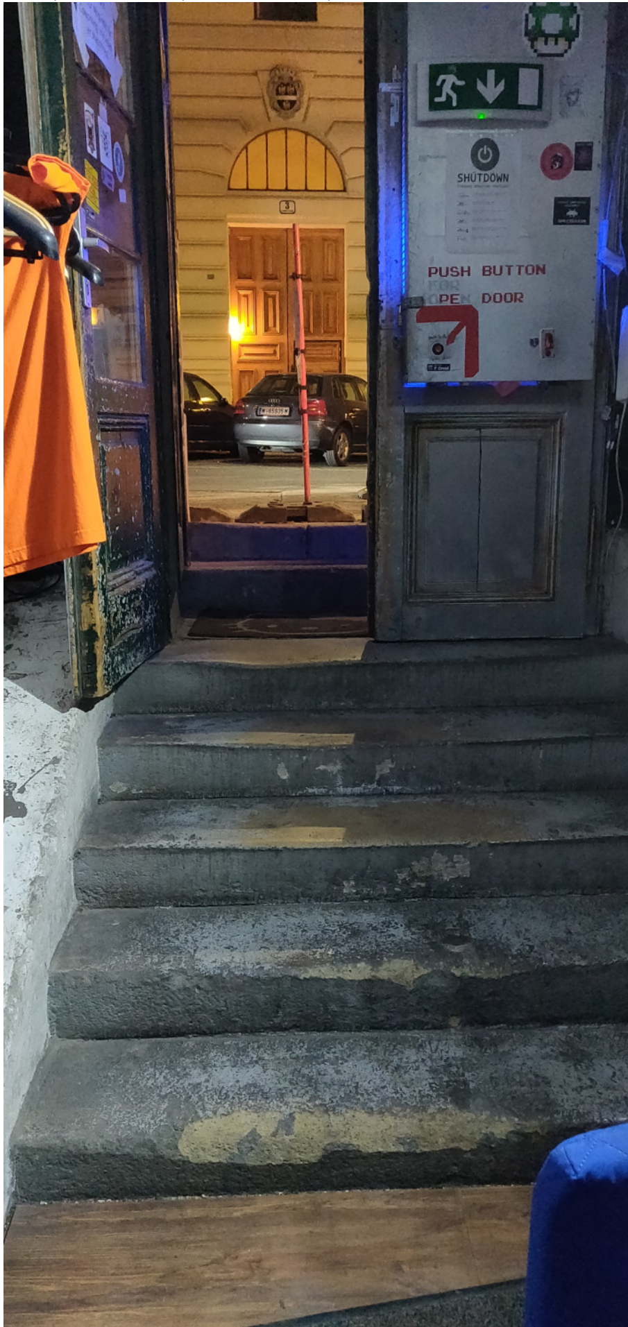
Eingang von Innen, 2 + 5 Stufen, Türe 127 breit, Raum 200 breit
